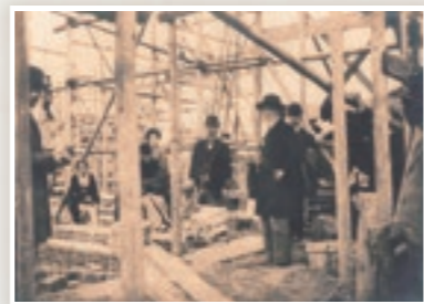
日本陶器 礎石の備え付け作業 Nippon Toki set the corner stone
